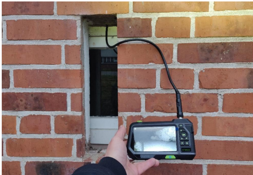
Abb. 17: Die Luftschicht zwischen Klinker und Mauerwerk an Gebäude A) besitzt ein hohes Quartierpotenzial für Fledermäuse.
